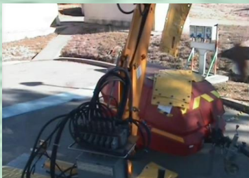
Dépose de matelas de plomb sur un module irradiant et contaminé
